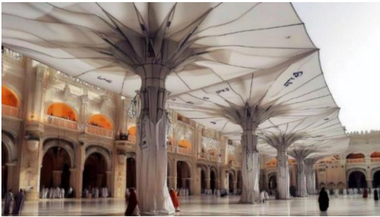
ภาพที่ 5 ระบบร่มบังแดดแบบพับเก็บได้ (Retractable shading system) (ที่มา : HISO., n.d.)
