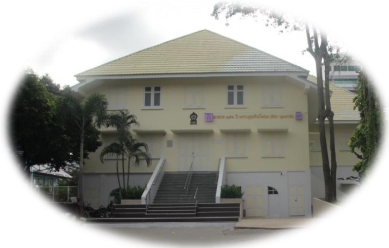
อาคาร ๑๕๐ ปี มหาบุรุษรัตโนดม (ช่วง บุนนาค)
